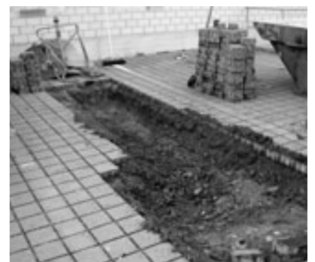
Sind Erdölprodukte ins Erdreich gelangt, muss nachgegraben werden.
